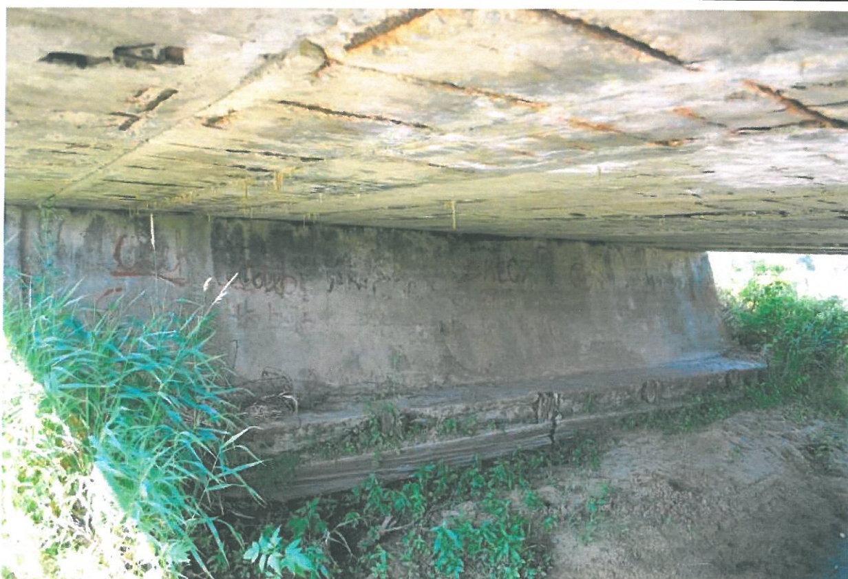
Fot. 4. Widok na przyczółek po stronie zachodniej.
