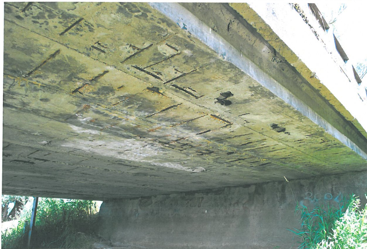
Fot. 2. Widok na spód konstrukcji nośnej obiektu.
