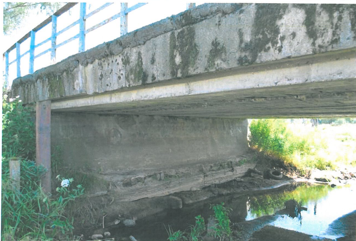
Fot. 3. Widok na przyczółek po stronie wschodniej.
